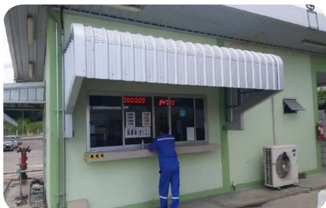
งานติดตั้งหลังคาบังแดดให้กับอาคาร Truckload เนื่องจากฝนตก ผู้ยื่นเอกสารในจุดดังกล่าวจะถูกฝนสาด และทำให้เอกสารการขนส่งเสียหายได้ Install a canopy to the truckload building to protect employees and documents from rain.
